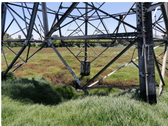
Figura 29. Torre de alta tensión Humedal Tunjo Fotografía de María Alejandra Piedra, SPPA, SDA, 2021.
